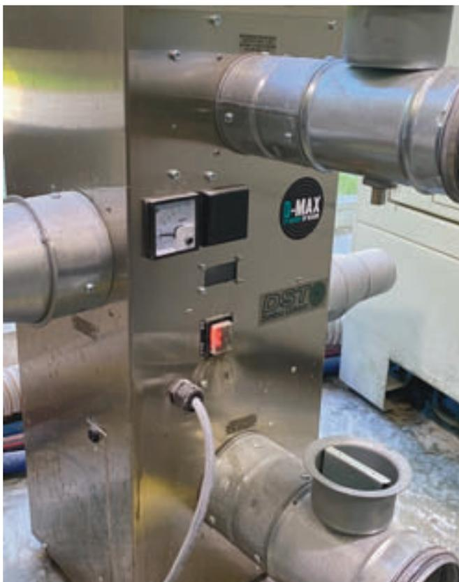
Luftentfeuchter an der Luftversorgung für den Bogentrenner.
